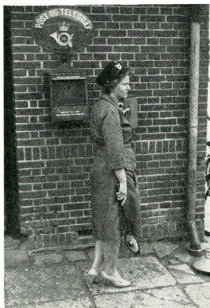
Den fungerende på Vestbirk station.
